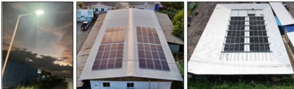
ติดตั้งแผงพลังงานแสงอาทิตย์สำหรับสำนักงานสนาม โครงการการติดตั้งคอมไฟโซลาร์เซลล์ ในบริเวณรอบโครงการสำนักงานสนาม และ Stock Yard
