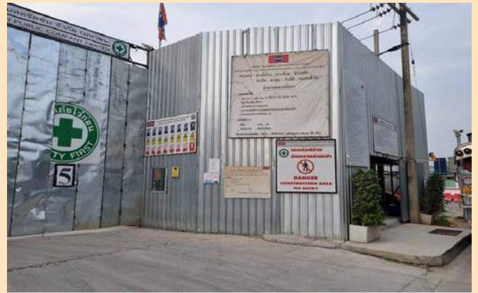
การจัดทำรั้วและป้ายเตือน “เขตก่อสร้าง”
